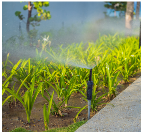
Hệ Thống Tưới Tự Động
